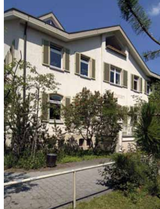
DAS »HAUS HÖCHSTEN« DER BEHINDERTENHILFE
