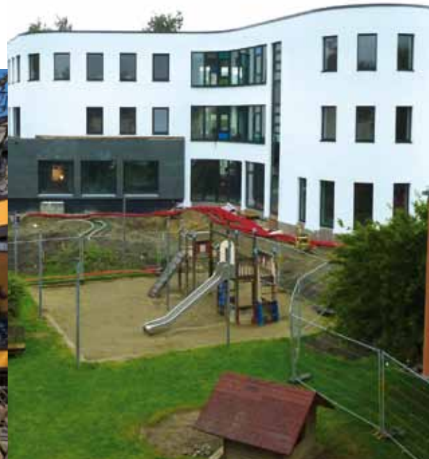
NEUBAU DER SPRACHHEILSCHULE IN ALTSHAUSEN
